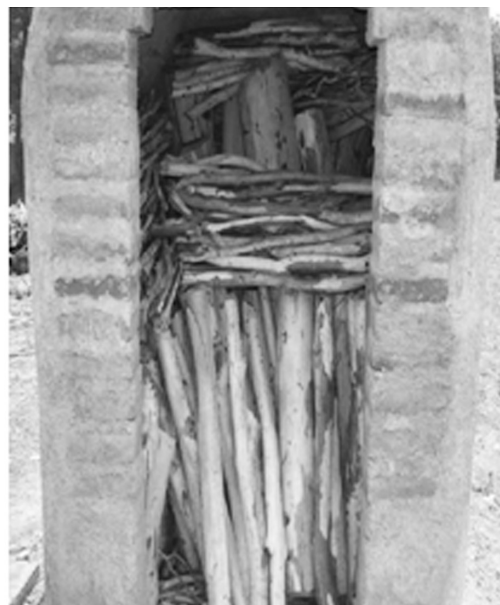
Figura 7. Horno de ladrillo al finalizar la etapa de carga.
