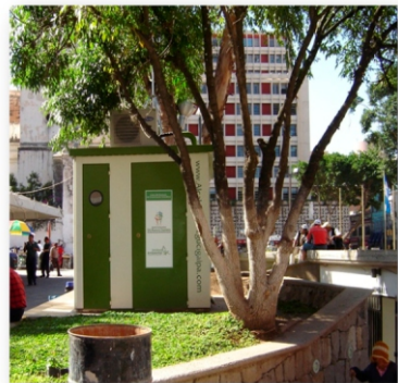
Figura 2. Cabina Automática en el Parque Central (CESCCO 2005)
