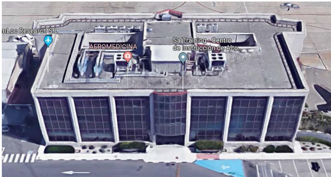
Figura 3: Vista general del edificio de servicios. Fuente: Google Maps.
