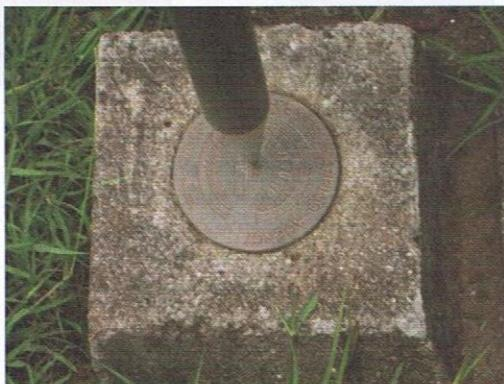
Figura 4.- Señal perteneciente al vértice del observatorio construida en la campaña geodésica de EE.UU. del año 1994
