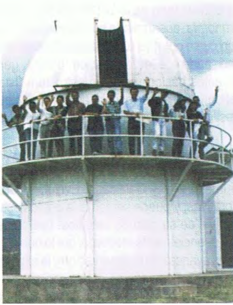
Figura 4. II. Acondicionamiento y puesta en funcionamiento de cúpula del Observatorio Astronómico de la Universidad Nacional Autónoma de Honduras. Ciudad Universitaria, Tegucigalpa. 1995-1996.
