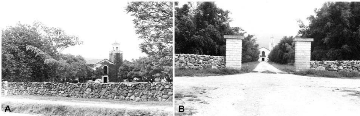
Foto 2. A. El Zemurray Hall visto desde la carretera Tegucigalpa-Danlí, el poste a la izquierda indica que es el km 36, este era el kilometraje entre Tegucigalpa y Zamorano al usar la carretera vieja que pasaba por El Jicarito y pasaba al lado de la Basílica de Suyapa en Tegucigalpa. Hoy el kilometraje es de solamente 30 km; la diferencia no se debe a que la nueva carretera es más corta, sino a que el kilómetro 0 no empieza en el Parque Central en Tegucigalpa, sino donde la carretera intercepta el anillo periférico [Amado Pelén]. B. Entrada al Zemurray Hall por la carretera Tegucigalpa-Danlí. Zemurray Hall fue auditorio, sale de cine y salón de clases por muchos años, recibió este nombre en honor a Samuel Zemurray Jr., hijo de Samuel Zemurray, Comandante del cuerpo de aviación del ejército de los Estados Unidos de América; falleció en acción el 7 de enero de 1943 en África durante la Segunda Guerra Mundial [Amado Pelén].
