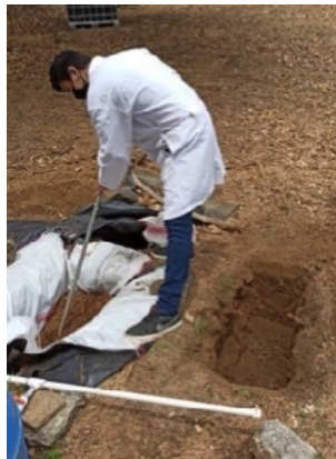
Figura 9. Construcción de las dos barreras reactivas permeables.
