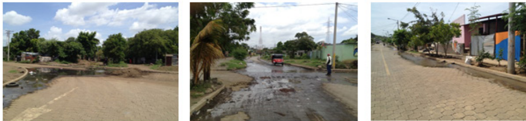
Ilustración 7: Fotografías de tres ejemplares de la infraestructura vial del Barrio Villa Guadalupe. Fuente propia 2015
