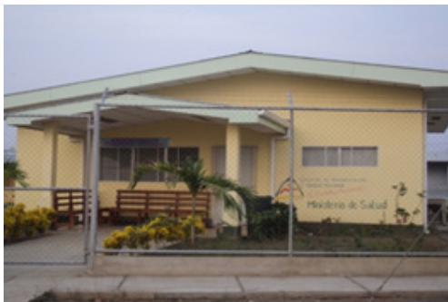
Ilustración 10: Imagen centro de salud del Barrio Villa Guadalupe, Fuente vía internet 2015
