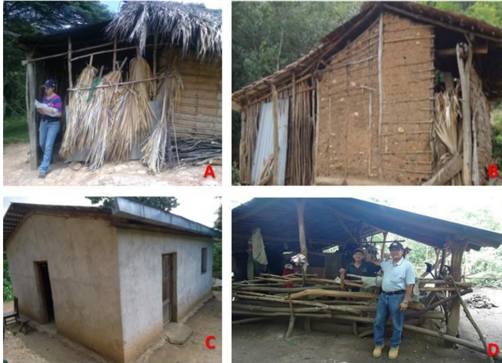
Figura 9. Fotografías de las viviendas de la Comunidad El Cacao. (A-B) Casas con paredes de taquezal, una con techo de palma y otra con techo de teja. (C) La única casa con paredes repelladas y que a su vez funciona como centro de salud. (D) Casa improvisada en donde habita la persona que donó el actual acuífero del que hace uso la comunidad.
