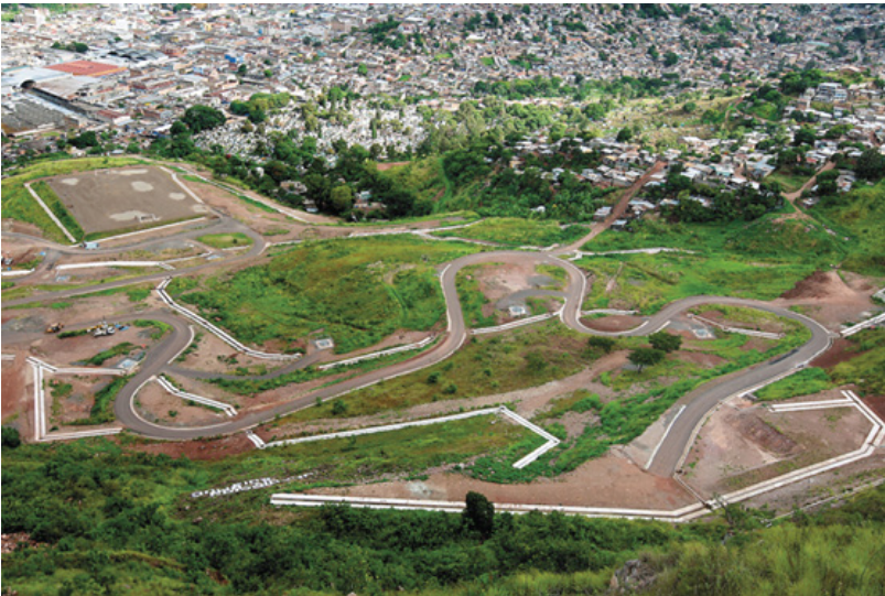
Figura 2. Obra de mitigación en Cerro el Berrinche.
