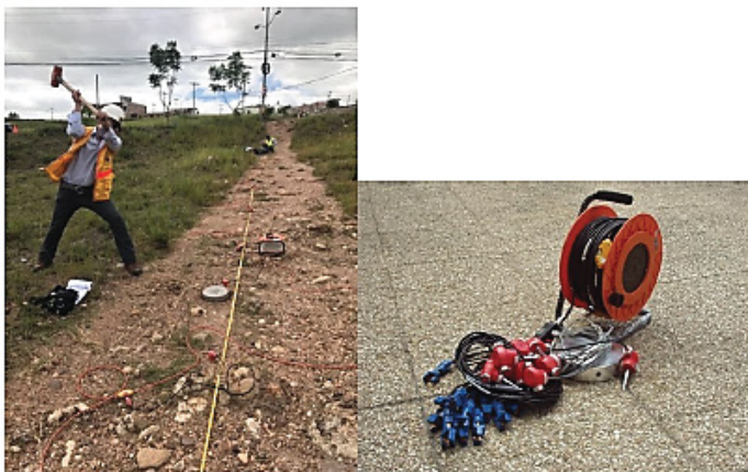
Figura 3. Equipo y golpeo del plato para obtener datos de Refracción Sísmica
