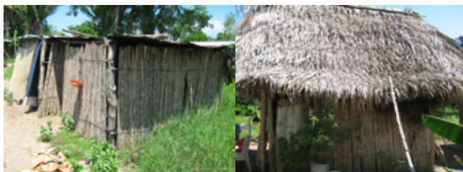
Viviendas con techo de paja y láminas de zinc, en la comunidad de Salado Barra.
