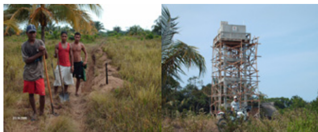
El aporte comunitario fue importante para la construcción del tanque de agua potable.
