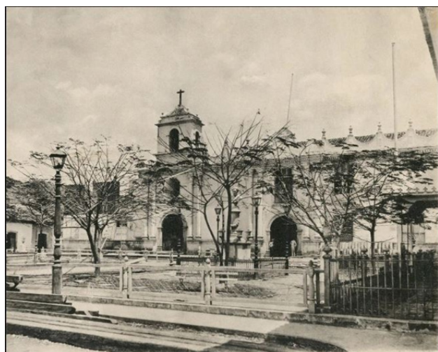
Imagen 3. Edificio de la Universidad Central y plaza La Merced, 1889.
