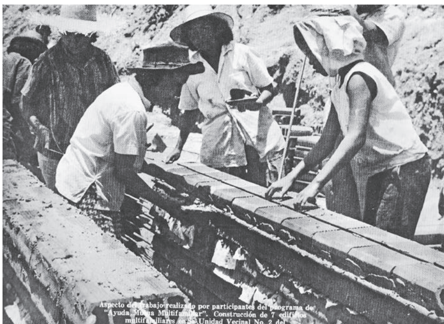
Fig. 12. Mujeres que participan en la edificación de unidades de vivienda multifamiliar como parte del proyecto de Autoconstrucción, en el Centro Urbano José Simeón Cañas, Mejicanos. Fuente: Memoria 1961-1967 , IVU.
