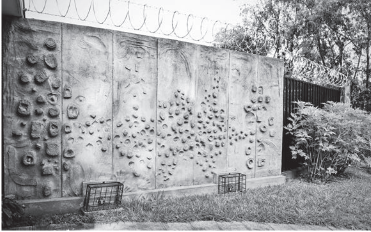
Fig. 6. Mural exterior en la Casa Díaz, Colonia Escalón (1965). Fuente: Guía de arquitectura de El Salvador (inédito).
