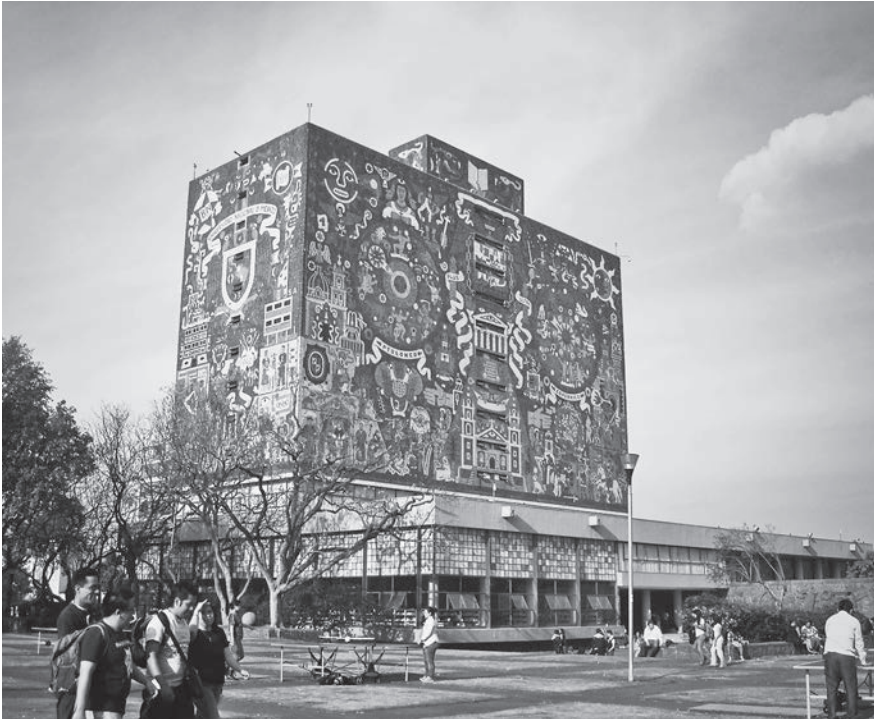
Fig. 1. Mural “representación histórica de la cultura” (1952) en la Biblioteca Central de la UNAM. Nótense las líneas modernistas del edificio en contraste con el mural de piedras naturales de O’Gorman. Fotografía de la autora, 2015.
