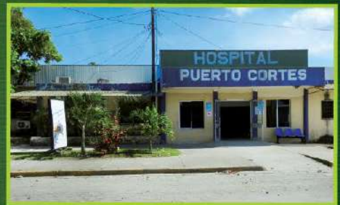
Hospital Puerto Cortés, Puerto Cortés, Cortés, Honduras.
