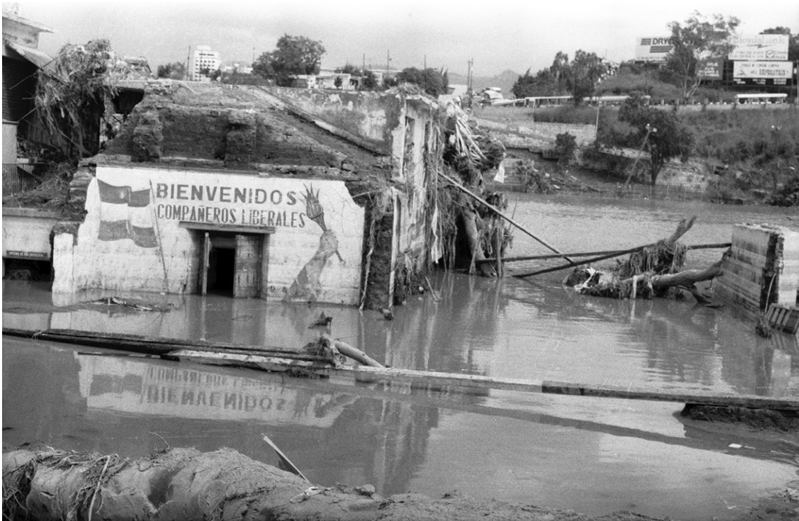
Escenas de la destrucción causada por la inundación de la primera y segunda avenida de Comayagüela al paso del huracán Mitch por la ciudad capital. Caminar sobre los escombros y tener el agua a la cintura era la única manera de captar esta imagen. Fotografía por Evaristo López Rojas, negativo en película blanco y negro 35mm. 1998
