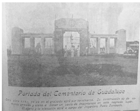
Foto 3: Construcción de la portada del Cementerio de Guadalupe [22]
