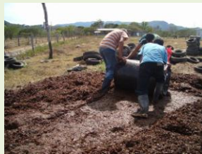
Compactación con barril lleno de agua
