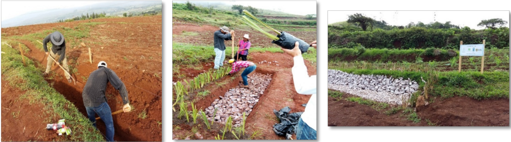
Figura 6: . Proceso de construcción de las galerías. Fuente: Foto propia para el estudio
