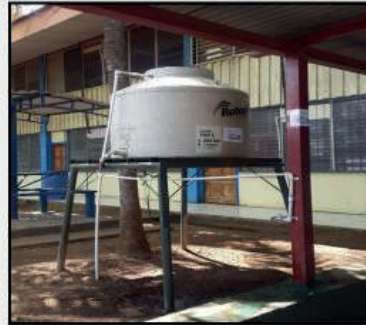
Ilustración 2. Instalación de tanque de agua para el lavado de manos
