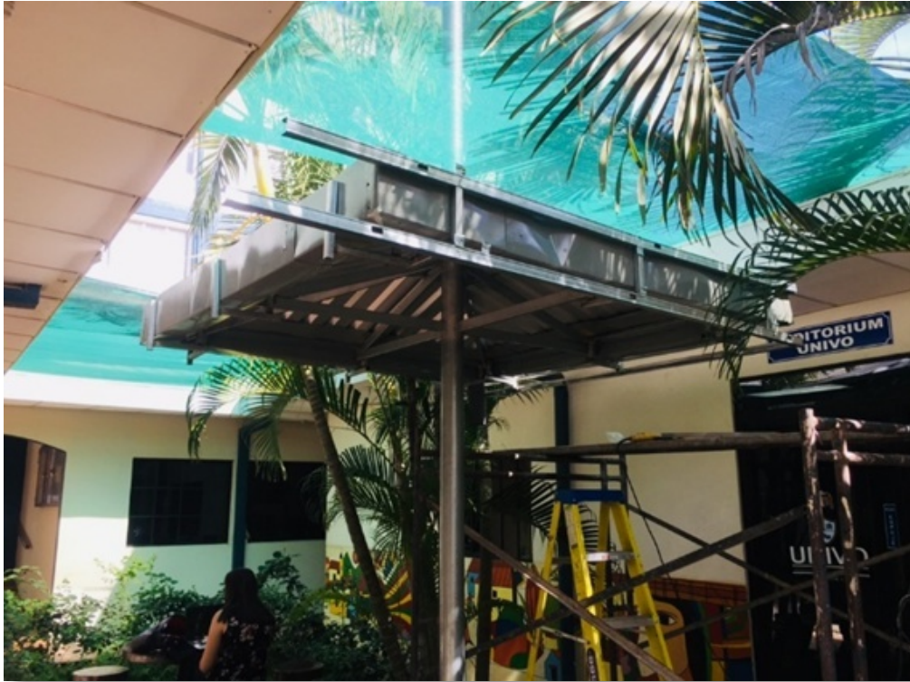
Figura 3. Instalación de la canaleta en el área perimetral.
