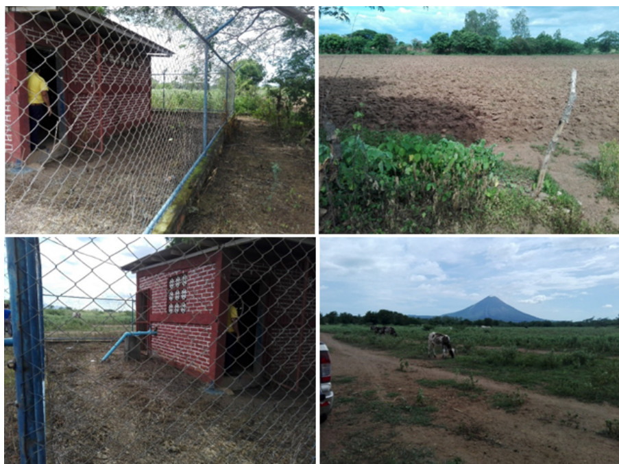
FIGURA 4 Pozo Perforado El Papalonal
